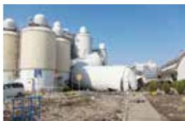
地震の揺れで倒壊した円筒型貯蔵タンク
